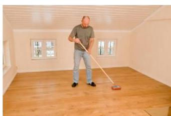
upravený povrch anebo jako vícevrstvý systém povrchové úpravy. Tvrdo-voskový olej se v převážné míře vsakuje do podkladu, ale zároveň vytváří na povrchu velmi tenkou a po vyzrání tvrdou odolnou vrstvu. Aplikuje se štětcem, hadrem, ale po naředění je možná i aplikace válečkem nebo stříkáním. Po částečném zaschnutí se tvrdo-voskový olej leští speciálním rounem. Na vyleštění podlah je nutné použít na to určené strojní zařízení. Tvrdo-voskový olej taktéž splňuje normu EN71-3 a DIN53169.
