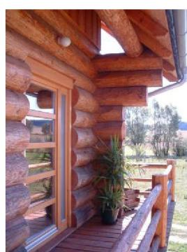
Povrchová úprava vhodným olejem na venkovní použití např. na srubovou stavbu, počítá nejen s tím, aby byl povrch dokonalý z hlediska přirozeného vzhledu a životnosti povrchové úpravy, ale i lehce udržovatelný. Po určitém čase je potřeba provést údržbu každého nátěru. Při olejovaných površích je však postačující očistění povrchu od prachu
